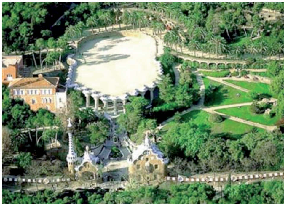
La Casa Larrard est la maison rose clair à gauche de la photo
